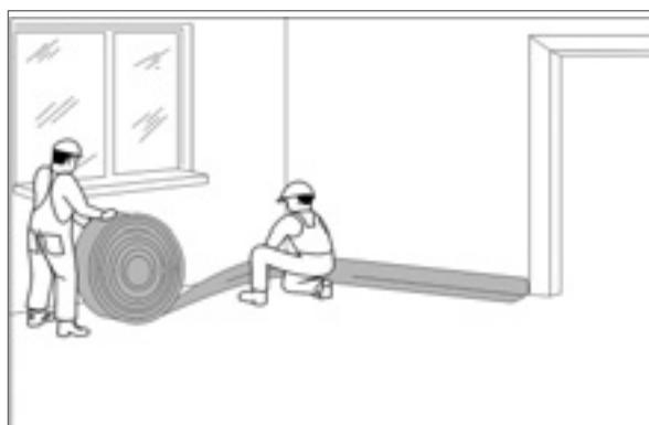
Рис.20. Раскладка под стеной краевой ленты.
