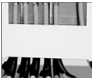
Рис. 26. Применение пластмассовых дуг, профилирующих выход труб из-под пола.
